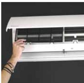
1. Aprire la paratia di alloggiamento del filtro antipolvere dello split e rimuovere il filtro.
