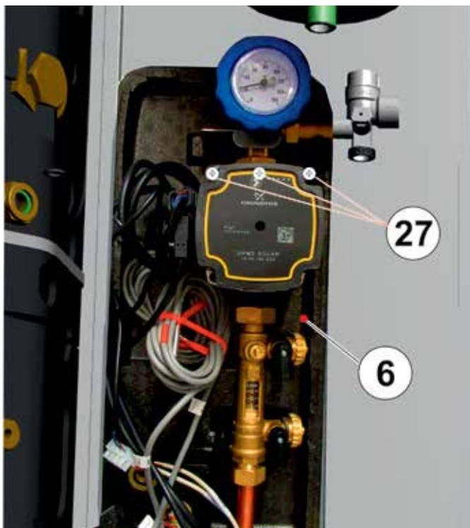
Fissare Centralina solare **6** al Box con **3 viti** auto-foranti **27**
