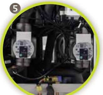
Pompa di circolazione maggiorata ad alta efficienza a modulazione totale e pompa scambiatore gas refrigerante
